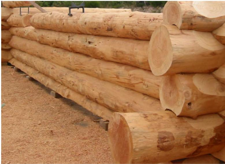
FIGURE 15 – Construction d'une fuste (fûts d'arbres, ou rondins, allongés et empilés).
