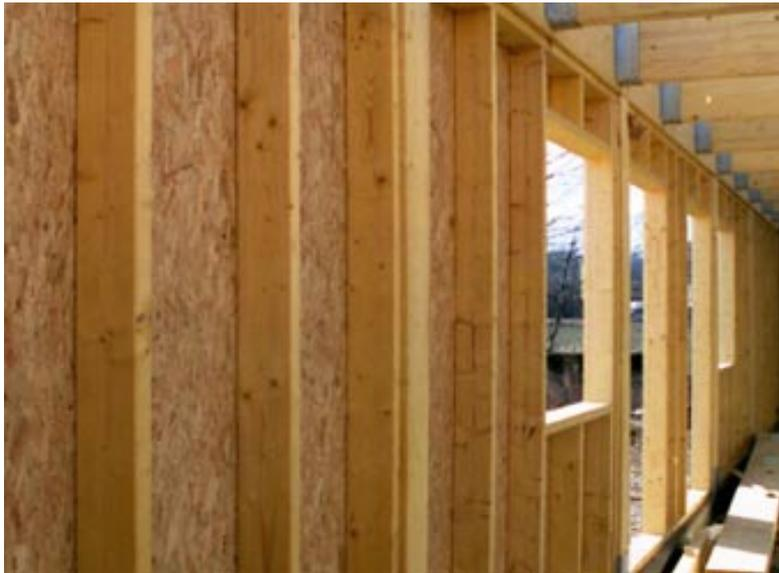
FIGURE 6 – Exemple d'utilisation de panneaux OSB pour contreventer une maison à ossature bois.
