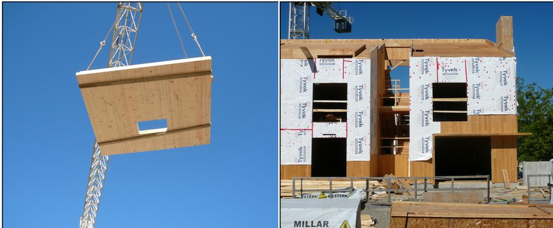
FIGURE 4 – Panneaux en CLT. Logements sur 3 niveaux à Vancouver (Canada). Crédit O. Gagliardini.
