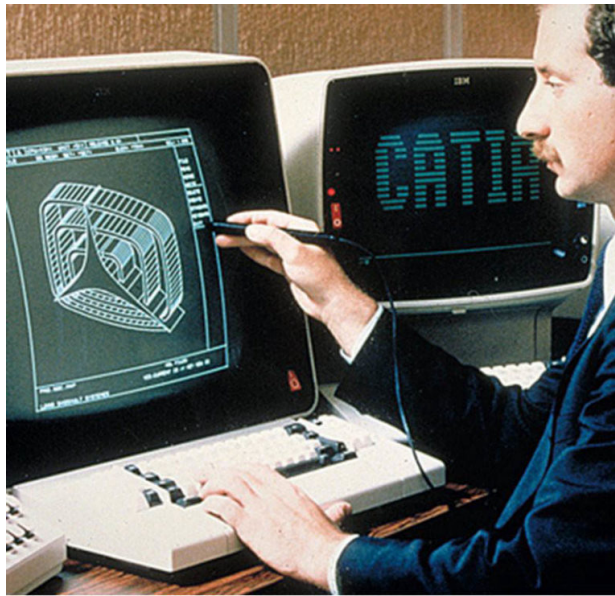
Catia V1 sur station IBM en 1982. Didier Gaillard fait une démonstration. L'écran de droite permet d'afficher les informations géométriques sur la pièce et ses caractéristiques tel que le centre de gravité, la masse.
